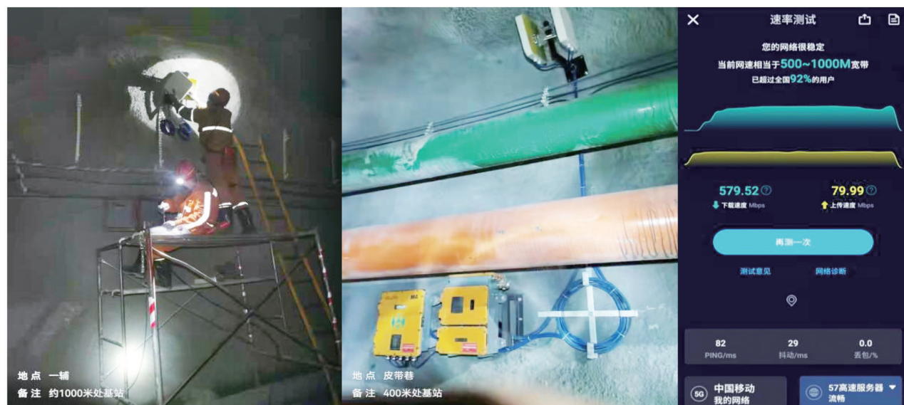
图4 巴拉素煤矿井下5G安装及传输测试
