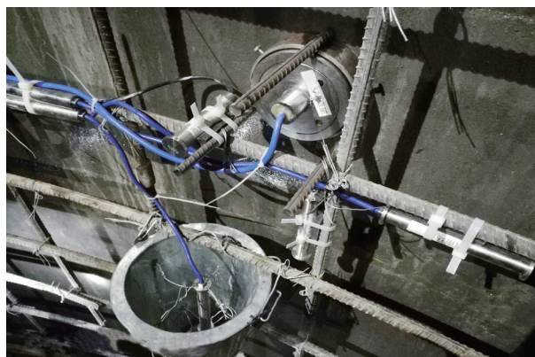
图2 传统定点测试传感器安装
