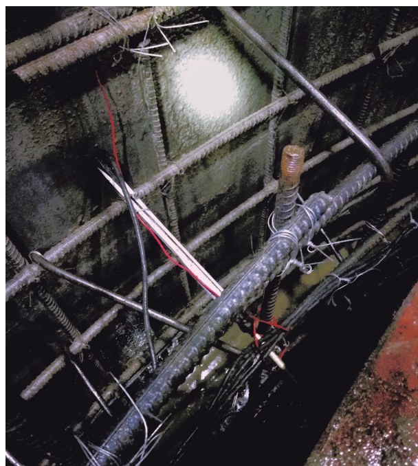
图4 机敏混凝土测试铜电极
