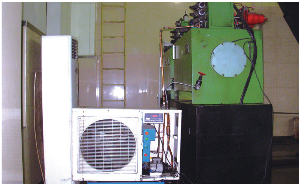
图2 矿井提升机液压制动冷却装置（第一代）
