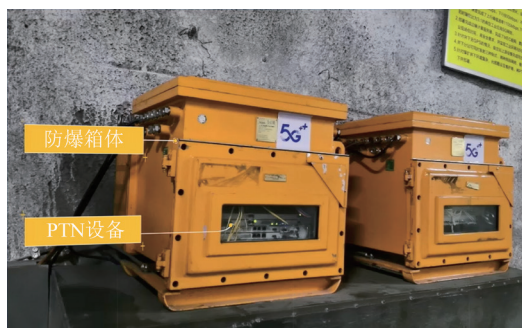
图3 新元煤矿井下环网汇聚站点
